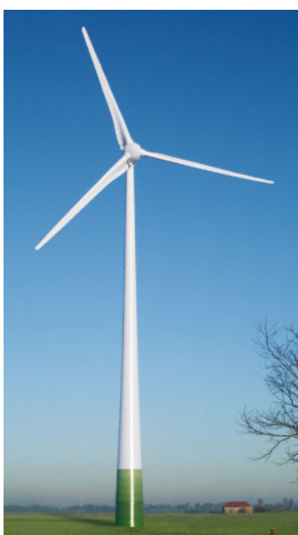
Abbildung 7-30: Windkraftanlage Modell Enercon E82 mit 2 MW Spitzenleistung und einem Rotordurchmesser von 82 m [Enercon 2009]
