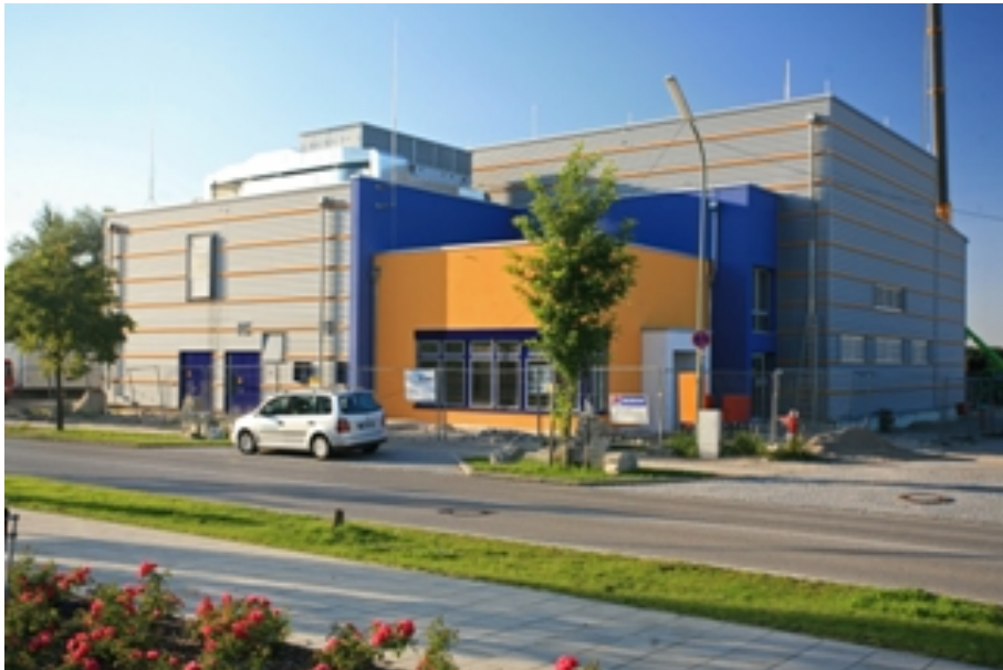
Abbildung 7-24: Geothermisches Kraftwerk in Unterhaching (Kalina Cycle) [Geothermie Unterhaching 2009]
