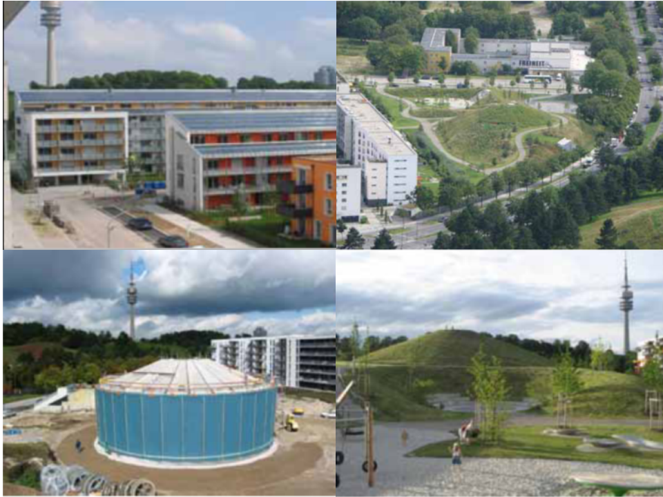
Abbildung 7-12 Impressionen des SNAP-Projektes in München; links oben Gebäude mit Solardächern, links unten Aufbau des Speichers, rechts verkleiderter Speicher [Arndt 2009]
